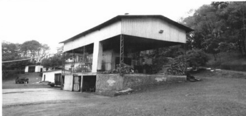
Figura F – Estrutura da Caldeira.
