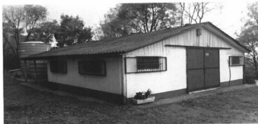
Figura J – Frente Refeitório e cozinha.
