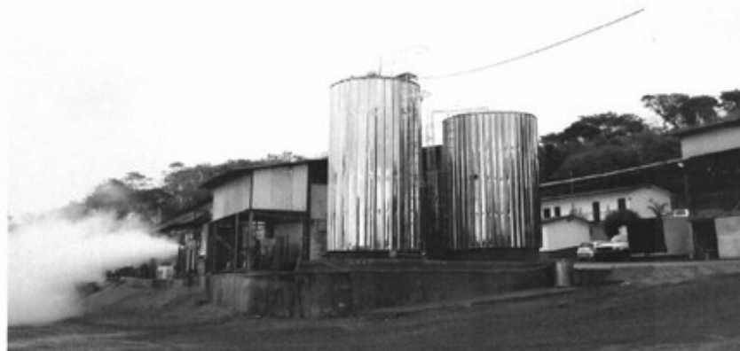
Figura E – Fundos pavilhão, tanques de recebimento do leite.
