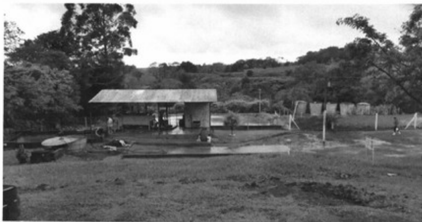
Figura O – Rampa de lavagem de caminhões e sistema de tratamento dos efluentes.
