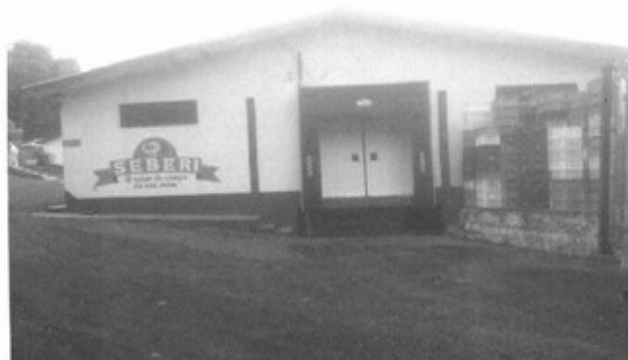
Figura D – Frente pavilhão.
