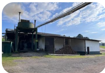
Prédio das caldeiras
